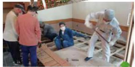
▲プロジェクトの拠点となる(旧)乃ざきうなぎ店の改装風景
